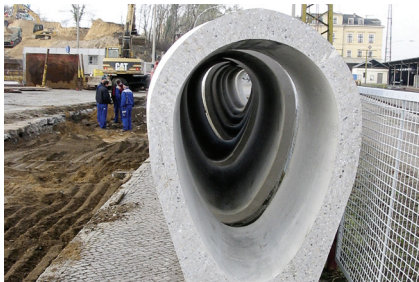
Bauvorhaben Bahnhofstr. in Riesa, Foto: Dr. J. Schultz
