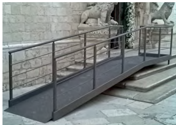
Figura 14 | Rampe per favorire l'accessibilità
